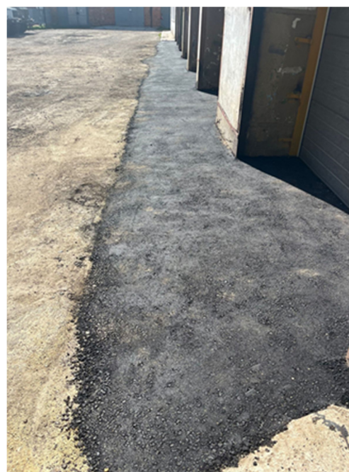
ремонт въездов гаража
